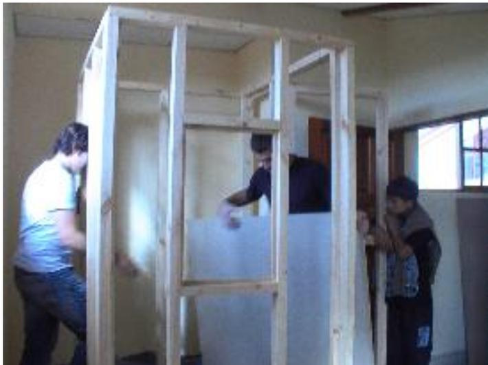
Um die Schallweiterleitung zu minimieren beklebten wir die Bretter mit einer Art Filzmatte, die man normalerweise bei Autos verbaut. Unsere 5kg Glaswolle reichten gerade mal für das Dach und eine Seitenwand und da wir keine 2 Wochen auf Nachschub warten wollten, verwendeten wir die Filzmatten auch um die Wände auszufüllen. Preislich kam das sogar auf das selbe raus und der Effekt war der gewünschte.
